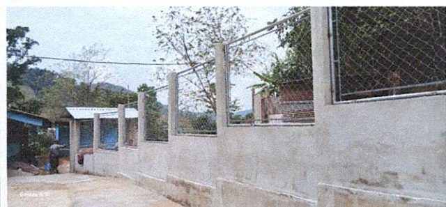
Foto 1: mejoramiento del muro perimetral con malla y columnas de concreto
