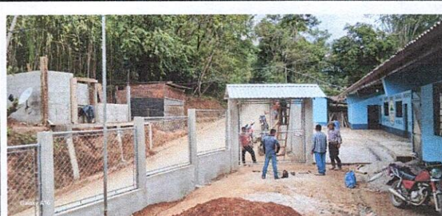
Foto 6: finalización del muro perimetral.
