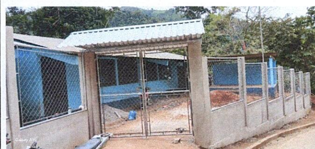
Foto 3: instalación de puerta nueva de malla y tubo galvanizado
